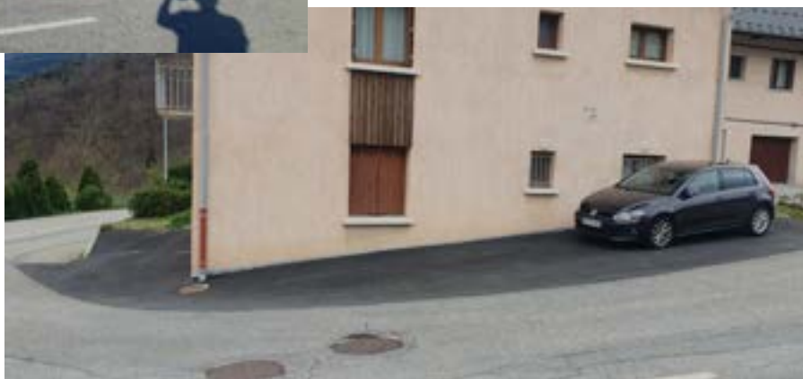
Enrobé dans le virage dit «de la Cure» au centre du village. Cela a permis de créer des places de parkings
