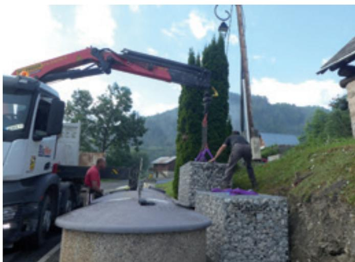
*Pose de gabions pour réaliser un mur de soutien au four des bottières*
